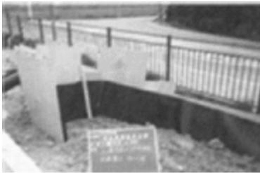
設置途中 設置時に塩ビは自立しないので板で支える
