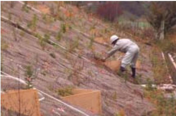
写真 作業員による植栽施工
