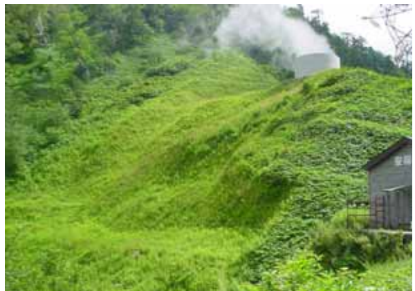
写真-4 2005年8月（施工後約8年） 全面緑化が維持されている。しかし、植栽木はほとんど目立たない。
