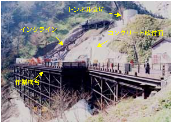
写真-1 1997年5月（施工前） トンネル立坑工事のために設置されたインクライン、作業構台が見える。後にこれらは全て撤去される。法面は、コンクリート吹付が施工されており、最上部には、コンクリート擁壁がある。
