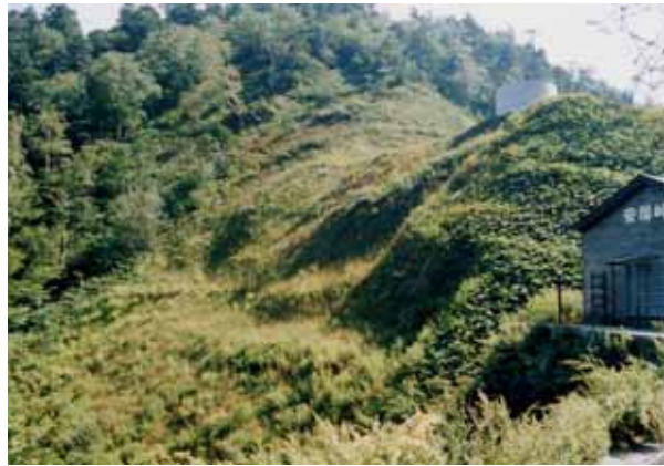
写真-3 2001年8月（施工後約4年） 植被率は、施工後3年で約90%、施工後4年で約100%となった。全面草本植物で覆われた。
