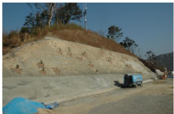
写真?5 エコプランター設置状況:植栽イメージが見えてきた(平成18年1月撮影:佐藤)
