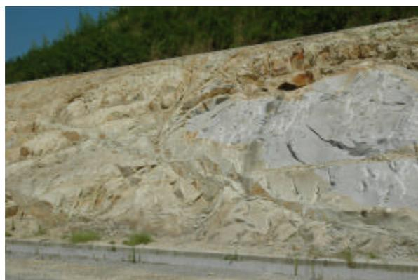
写真?3 砂岩法面: 植栽可能な亀裂や湧水が見られる砂岩および露出させる岩盤部分(平成18年1月撮影:佐藤)
